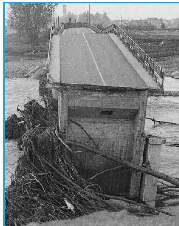
Il ponte sulla provinciale per Bosco parzialmente crollato in seguito alla piena del '77
